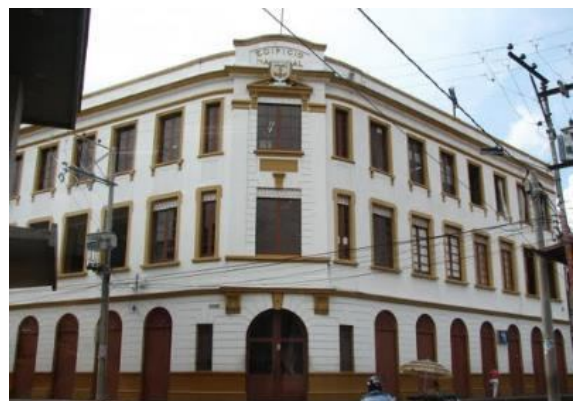
Fig.24. Edificio Nacional (Estado Actual)
