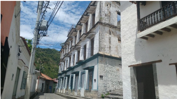
Fig.25. Edificio Fayad (Estado Actual)
